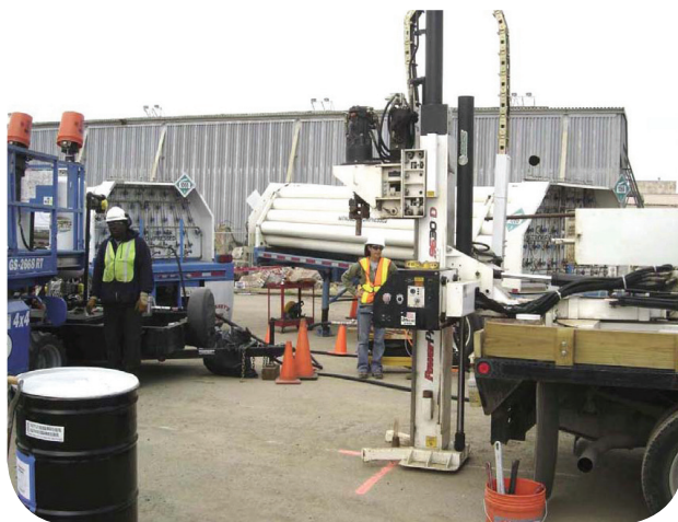
Fracturación neumática en el sitio Superfund del Astillero Naval de Hunters Point.
